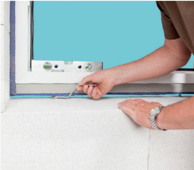
Der Tragteller JUSTA® TT und der Befestigungsanker JUSTA® BA bestehen jeweils aus einem flachen Metallteller bzw. einer flachen Ankerlasche, an dem/der eine Justierschraube und eine Justiermutter drehbar angebracht sind. Die Justierschraube wird mit einem Bit und
