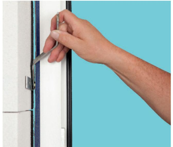
einem Elektroschrauber in die Blendrahmenunterseite eingedreht. Mit der Justiermutter wird das Fensterelement exakt ausgerichtet. Dazu wird mit dem hierfür konzipierten ratschenden JUSTA® Montageschlüssel geschraubt.
